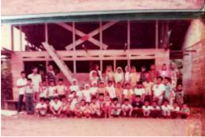
Lantai dasar Ruang kelas Madrasah Diniah Zainiah di Teluk Jolo dan lantai 2 dipakai untuk Musholla.
