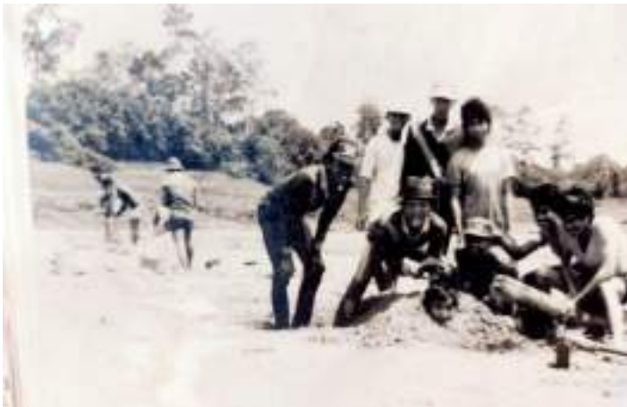
Aku dikubur saat kerja bakti ambil pasir untuk pembangunan Masjid Al-Manar Puruk Cahu 1984
